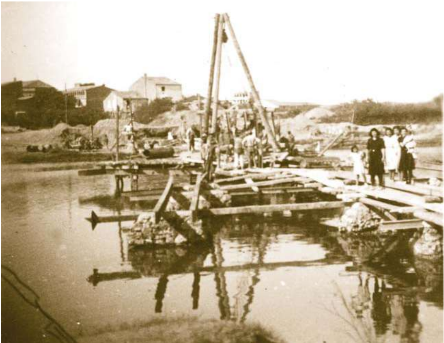
Figura 47. Construcció del passallís sobre el Fluvià a Sant Pere Pescador. 1927
