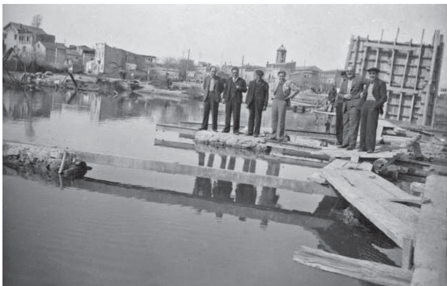
Figura 51/52. Obres de construcció del pont de Sant Pere Pescador. 1941
