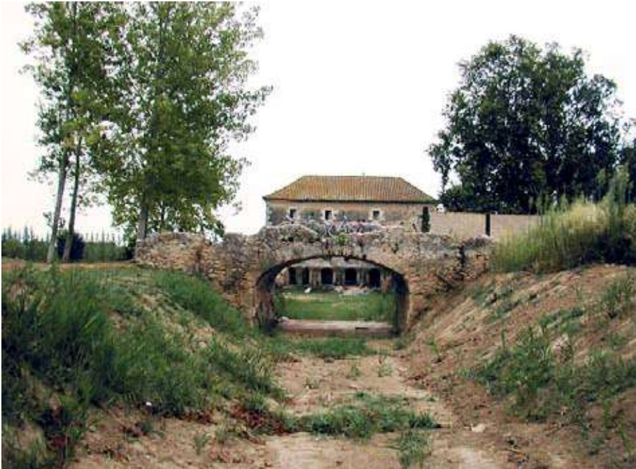
Figura 18. Vista del molí de l'Armentera des del rec del mateix nom. A la imatge, el conjunt hidràulic es trobava en procés de rehabilitació. 2006. Autor: Josep Tornafoch
