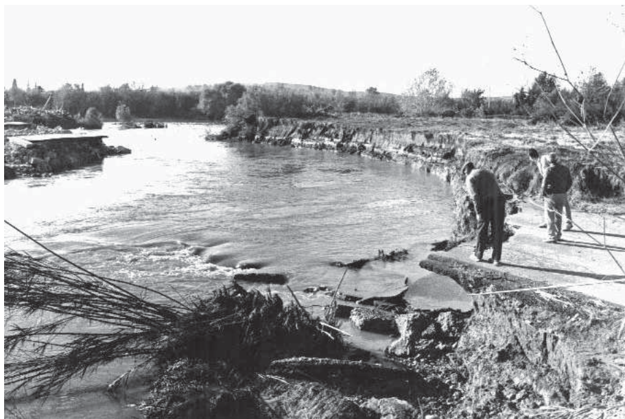
Figura 54. El passallís sobre el Fluvià al seu pas per Torroella de Fluvià destruït per les inundacions del 12 de novembre de 1988
