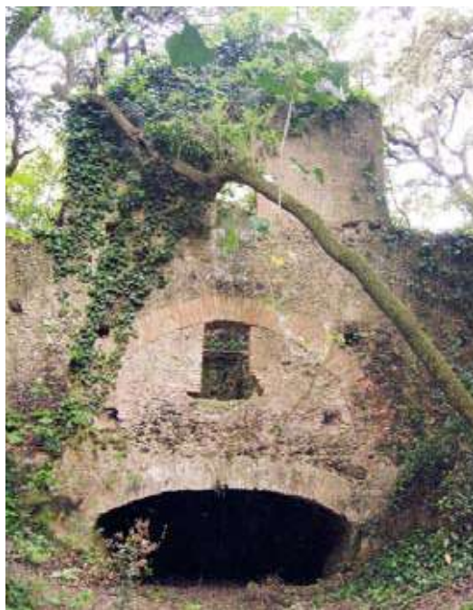
Figura 20/21. El cadirat amb les tres comportes, Roques del Tit (Vila-robau, Ventalló). 2010. Autor: Josep Tornafoch
